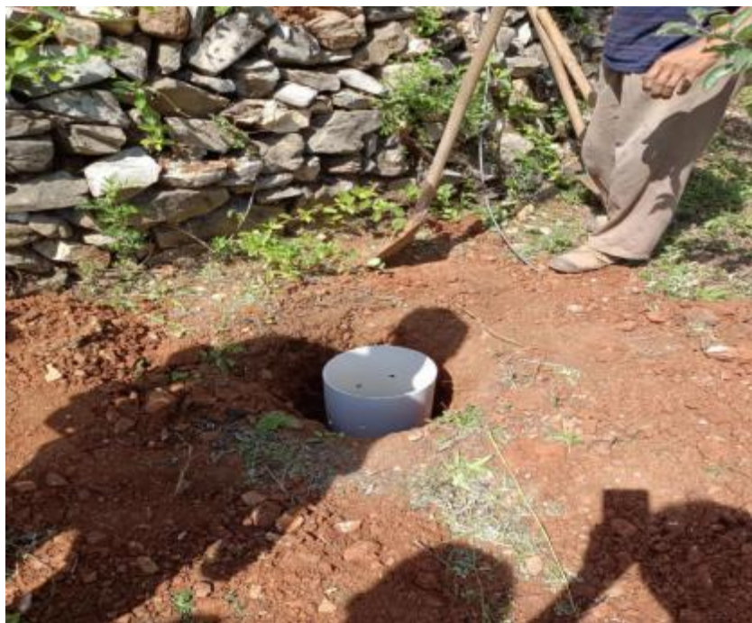
雨水收集装置埋设
